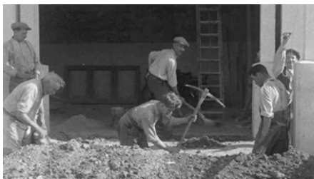
Ouvriers sur chantier
